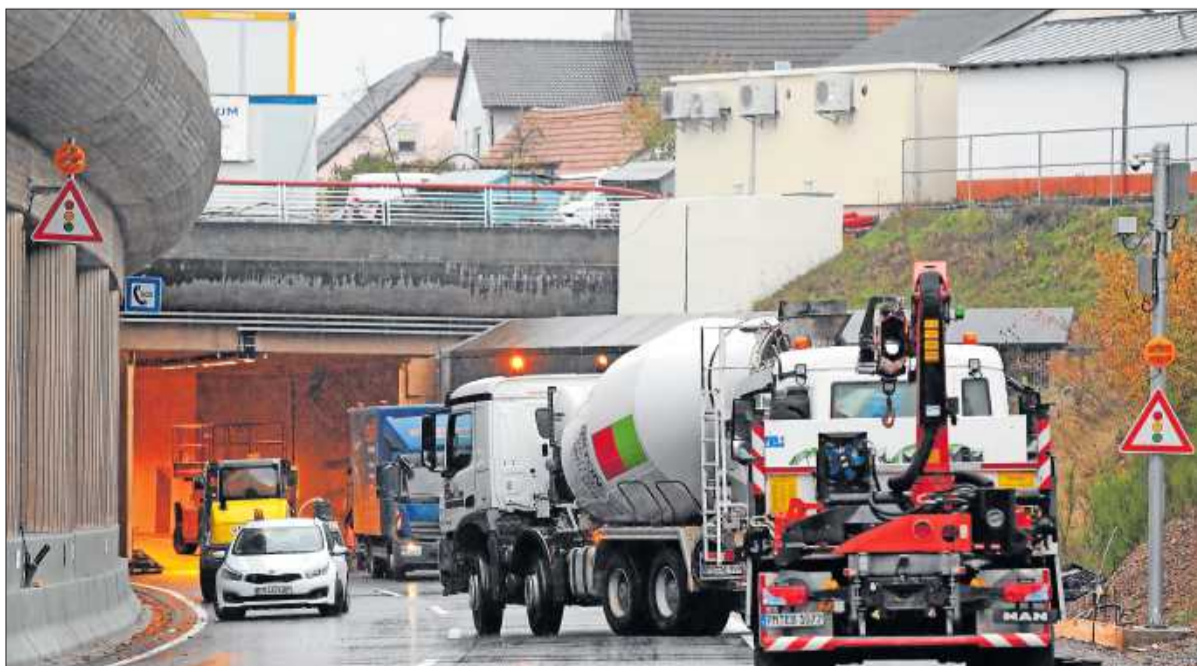
Auf Hochtouren laufen momentan die Bauarbeiten für die Modernisierung des Brandschutzes und der technischen Anlagen im B 10-Fehrbachtunnel. (Foto: Scharf)
